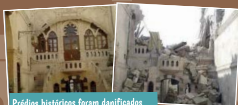
Prédios históricos foram danificados
