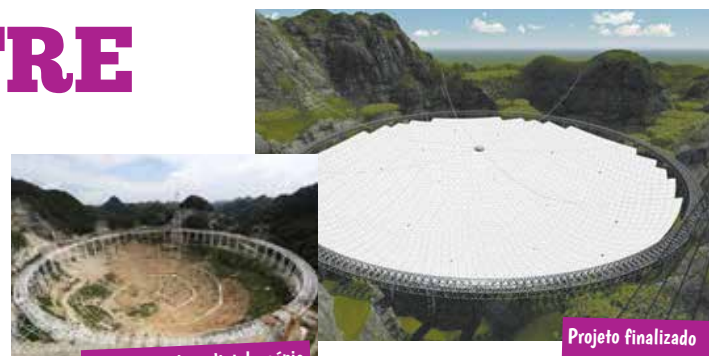
Construção do radiotelescópio
